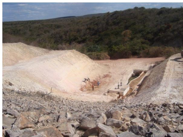
Figura 54 - taludes da tomada d'água após a estabilização dos taludes
