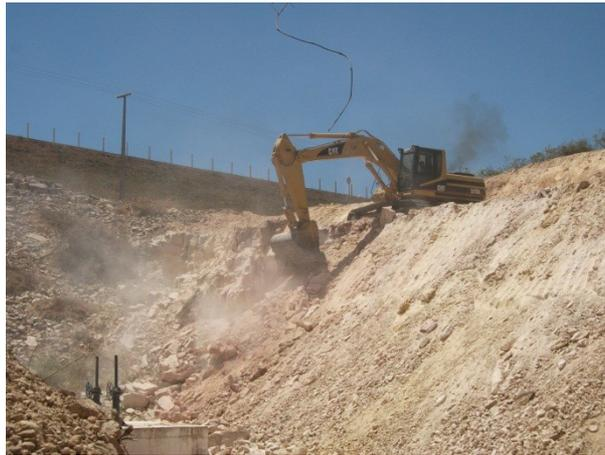
Figura 52 - detalhe da execução da estabilização dos taludes
