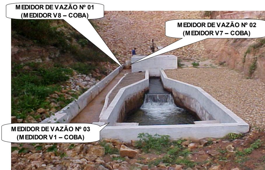
Figura 1 - medidores de vazão nº 01, 02 e 03 (COGERH)
