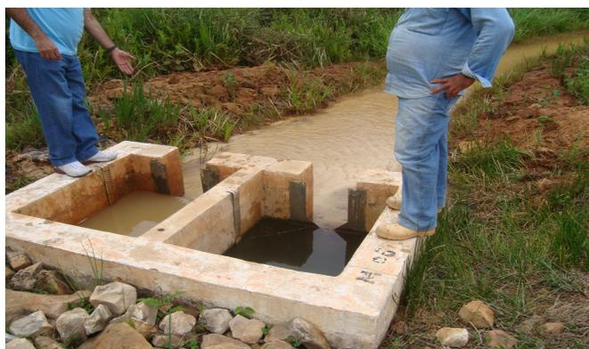
Figura 19 - vista dos medidores V-7(E) da revência na ombreira esquerda e V-6 (D) da fund da barragem
