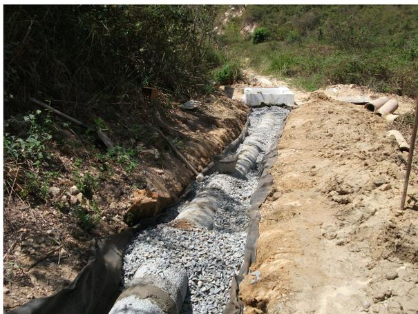
Figura 48 - execução da drenagem do medidor de vazão V-12
