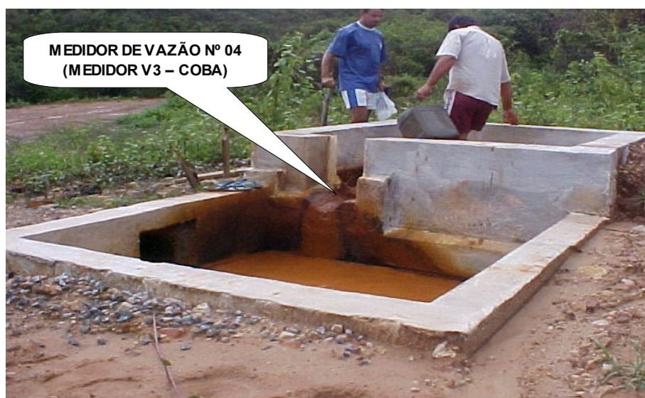
Figura 2 - medidor de vazão nº 04 (COGERH)
