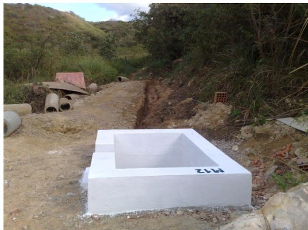
Figura 46 - detalhe da execução da caixa medidora de vazão V-12
