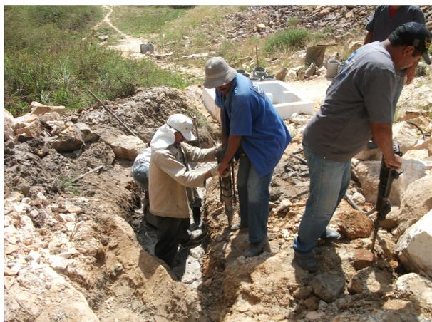
Figura 47 - escavação da vala da drenagem para os medidores de vazão V-10 e V-11
