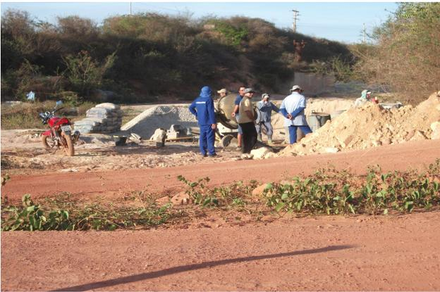
Figura 39 - preparação da área para colocação do concreto magro
