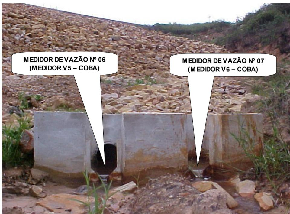
Figura 4 - medidores de vazão nº 06 e 07 (COGERH)
