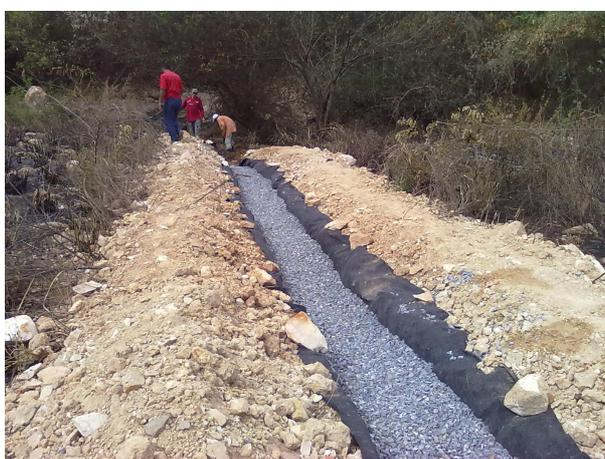
Figura 49 - execução da drenagem da surgência para o medidor de vazão V-05
