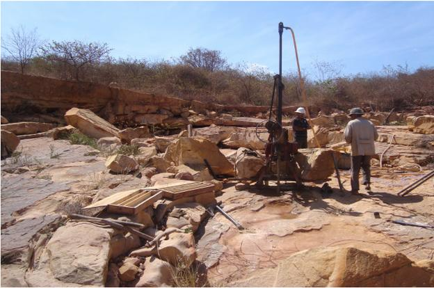
Figura 38 - execução de sondagens no canal de restituição
